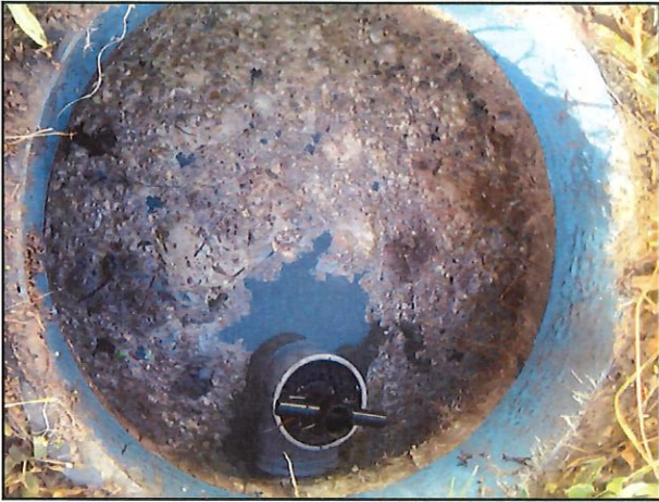
Rampe du système de distribution de l'eau sur le média filtrant qui n'est plus correctement fixée
