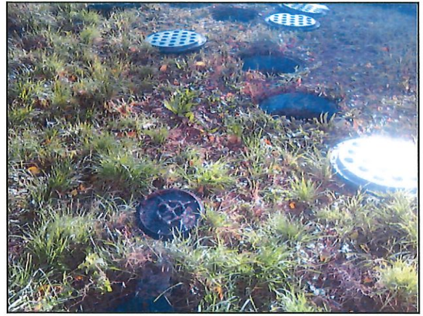
Extrémité de la ventilation secondaire
